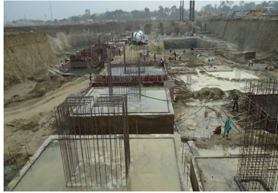
कोराडी टर्बाइन फाऊंडेशन संच क्रं ९ (३×६६० मेगावॉट प्रकल्प)
